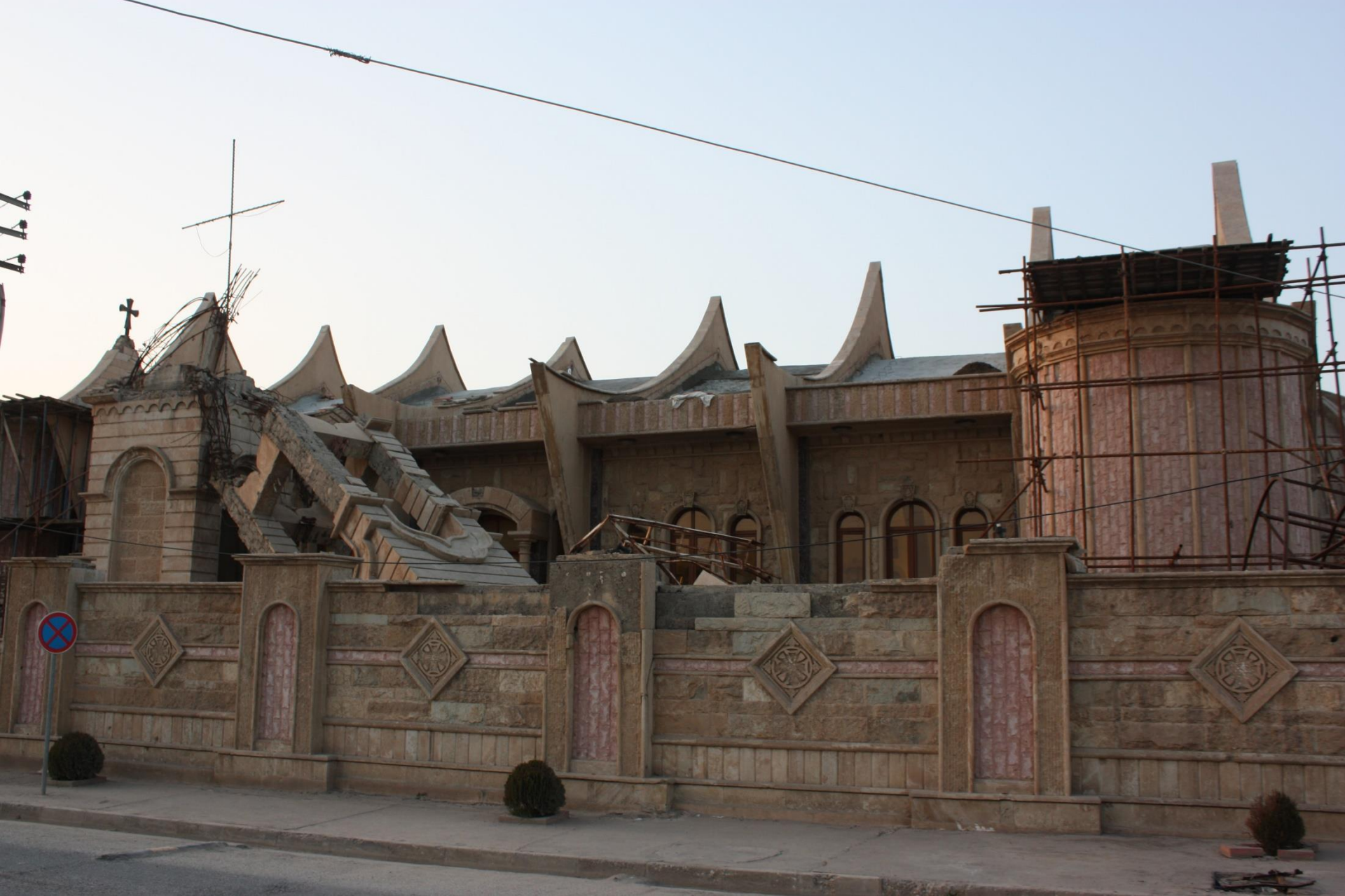
Eine zerstörte Kirche in Karakosch, die gerade von CAPNI wieder repariert wird. U.a. war der Kirchturm vom IS gesprengt worden.
